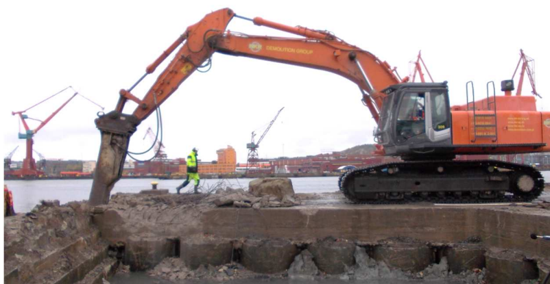
Figur 1. Rivning av Stenpiren på Skeppsbron i Göteborg med hydrauliskhammare. Ekvivalent ljudnivå uppmättes till 86 dBA på 20m avstånd.
