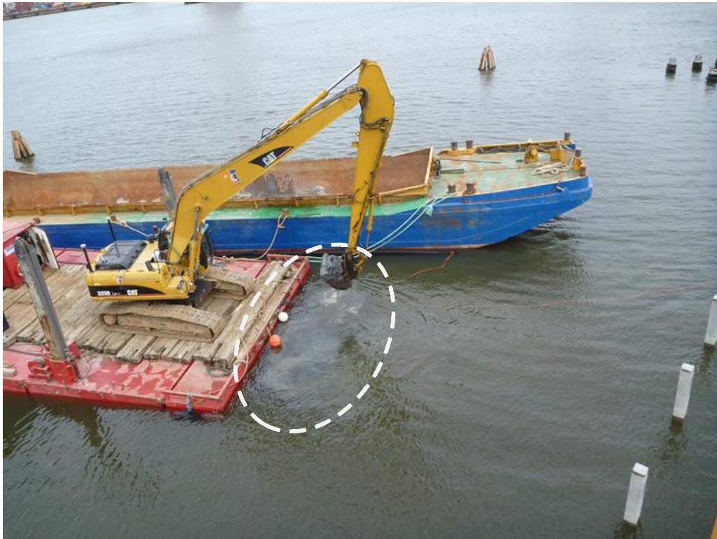
Figur 9-1, Lokal grumlingsplym kring enskopeverk i samband med muddring utanför Skeppsbron 2014.
