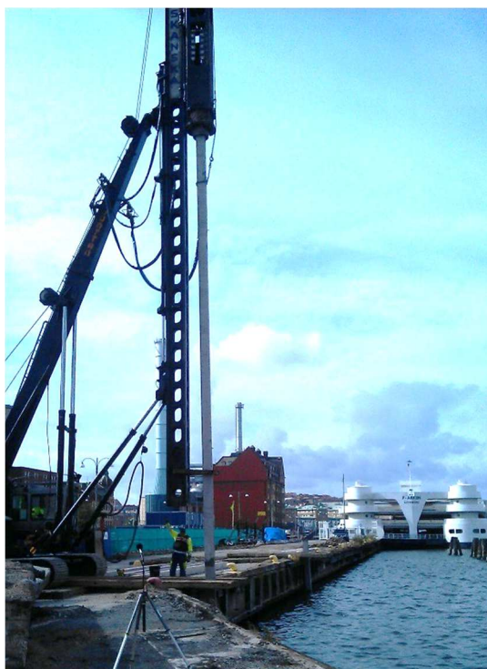
Figur 3. Betongpålning i vatten på Skeppsbron i Göteborg. Ekvivalent ljudnivå uppmättes till 77 dBA på 20 m avstånd för pålning ner till 50 -60 m djup inkluderat stoppslagning. Fallvikt 4 ton med sandfylld hylsa.
