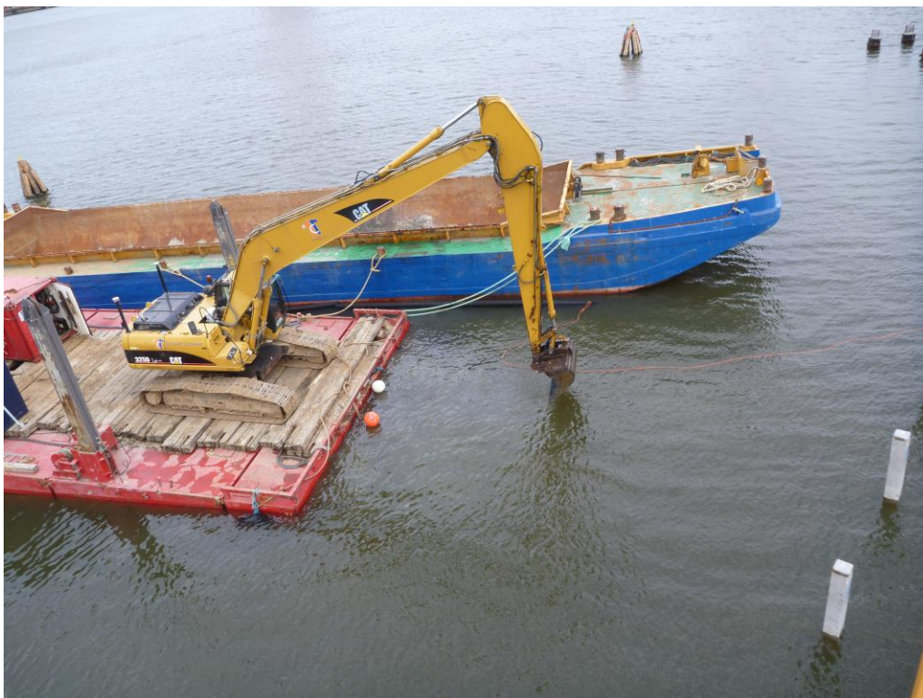
Figur 9-2, Den grumlingsplym som uppstår lokalt kring enskopeverket när skopan lyfts upp över vattenytan hinner sjunka undan inför nästa skoptag, Skeppsbron 2014.
