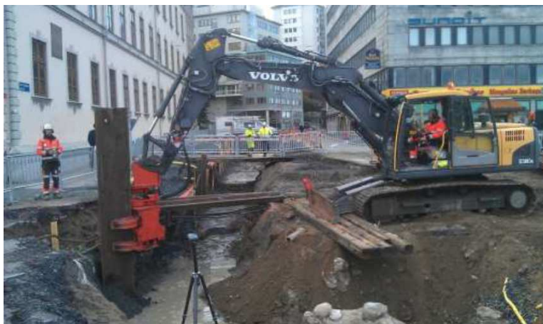
Figur 4. Spontning på Skeppsbron i Göteborg Ekvivalent ljudnivå uppmättes till 68 dBA på 20m avstånd för "mindre spont" ner till 4-7 m djup.
